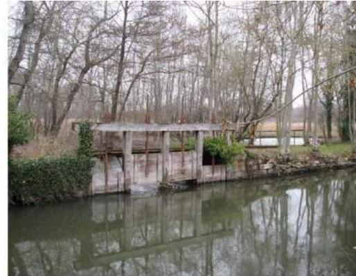
largeur de 1.75 m. Le débit de l'eau était régulé par une vanne plongeante actionnée par un système d'engrenages.
