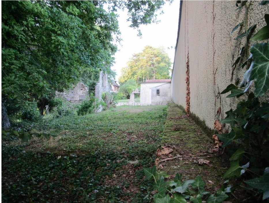
Le mur nord de l'ancien verger, le séparant des « ruines » L'une des ruines est visible à gauche de la photo, invisible du verger du fait de ce mur.
