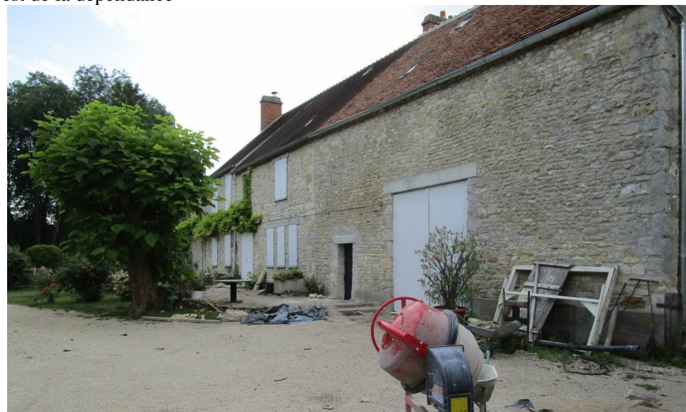
Maison d'habitation, en travaux d'entretien : le niveau du sol est plus élevé que dans la cour
