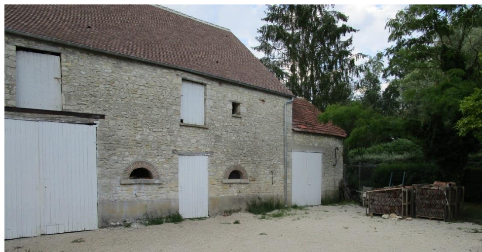
Façade ouest, dont la toiture a été reprise récemment
