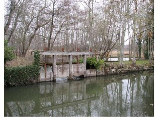
largeur de 1.75 m. Le débit de l'eau était régulé par une vanne plongeante actionnée par un système d'engrenages.
